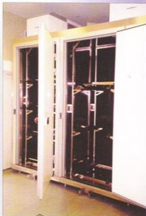
Zblokowane 2 komory chłodnicze na 11 trumien, krematorium PPU "Zieleń" w Gdańsku.
