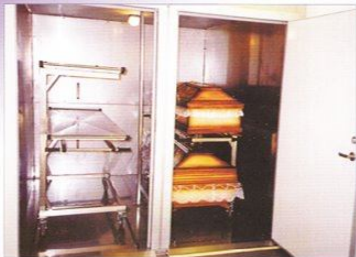
Komora chłodnicza w systemie wózkowym na 5 ciał (2 trumny i 3 tace), 2002 r., Włocławek.
